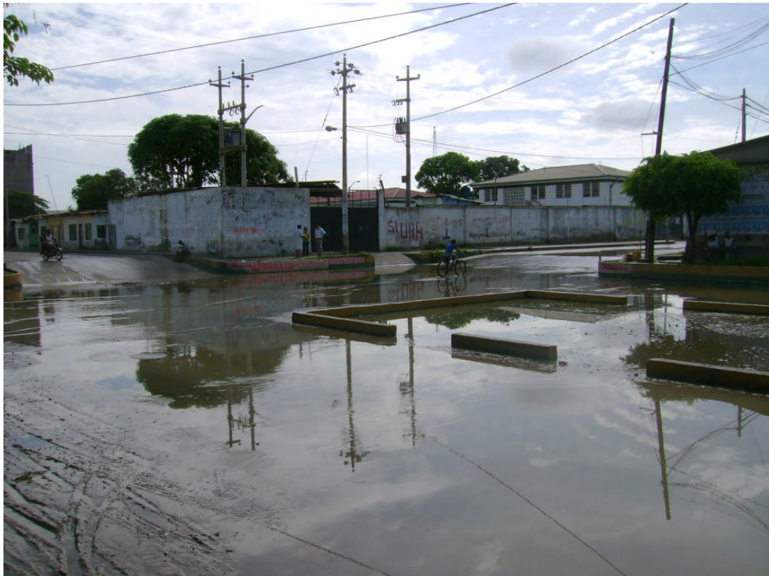
Riesgo por la vulnerabilidad del sistema de agua y alcantarillado, tomadas en la Calle Arica del Barrio San José – Tumbes Creditos: David Alcocer
